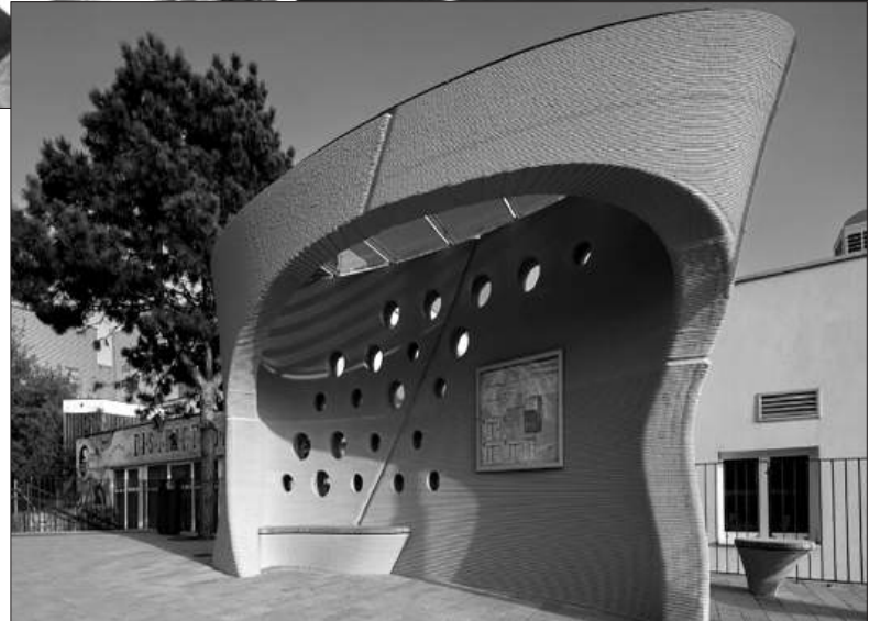
Nhà chờ xe buýt được chế tạo bằng công nghệ in 3D tại Slovakia.
