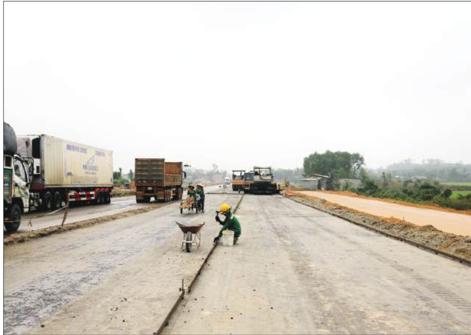
Dự án cao tốc đoạn Hòa Liên - Túy Loan đang giai đoạn nước rút.
